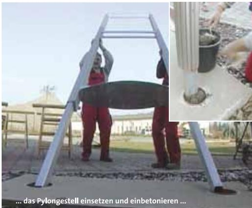
... das Pylongestell einsetzen und einbetonieren ...
